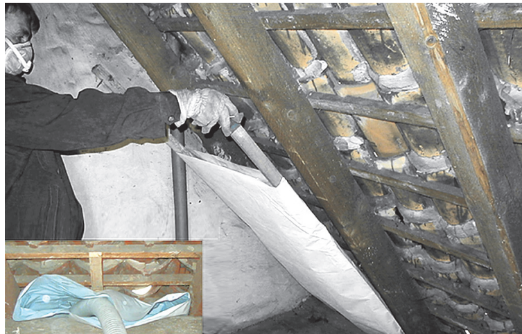
Kann man vom Spitzboden aus die Ziegel sehen, können Dämmsäcke in die Hohlräume zwischen den Sparren eingeschoben werden und mit Zellulosedämmung gefüllt werden.
