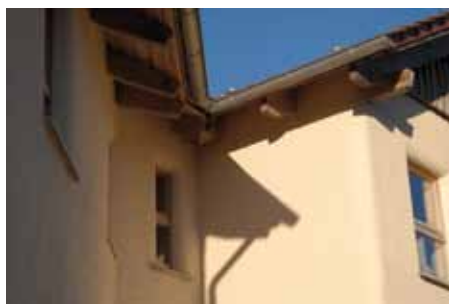
Kalkputz mit Anstrich außen.
