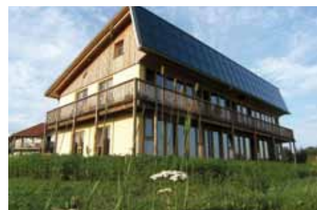
Solarpassiv-Strohhaus.
