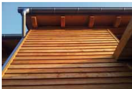
Holzschalung vor Lehmputz außen.
