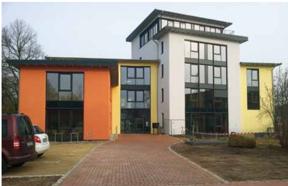
Das weltweit erste strohgedämmte Bürogebäude mit fünf Geschossen in Verden/ Aller.
